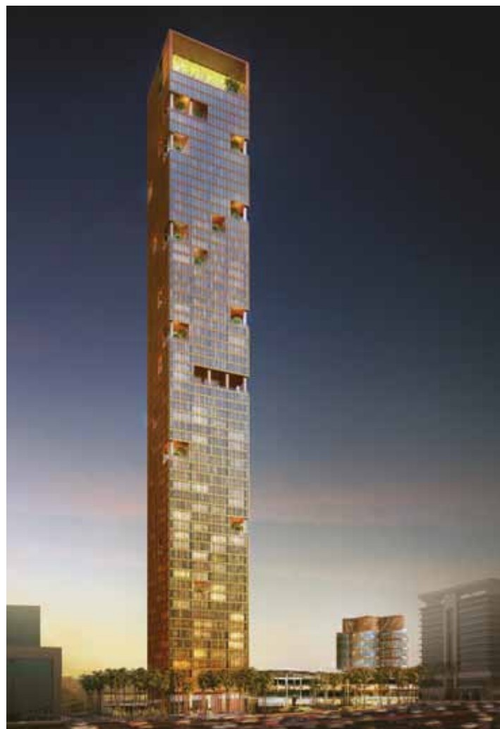
Concurso Kempinski Rafal Tower, Riade, Arábia Saudita, 2014 (em construção)
